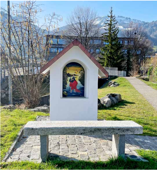
Das Helgenstöckli nach der Sanierung.
