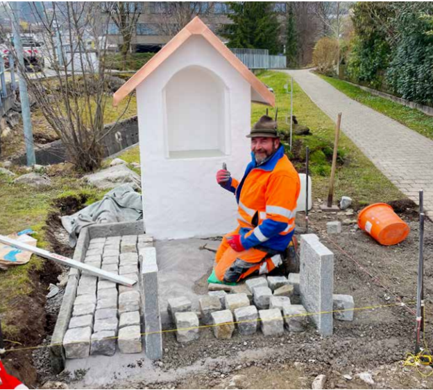
Paul Waser bei den Sanierungsarbeiten.
