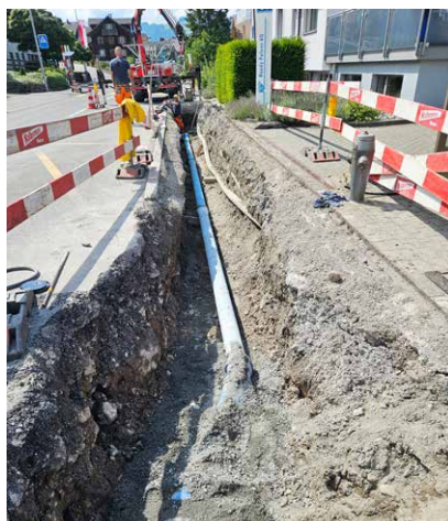
Sanierungsarbeiten auf der Buochserstrasse.
