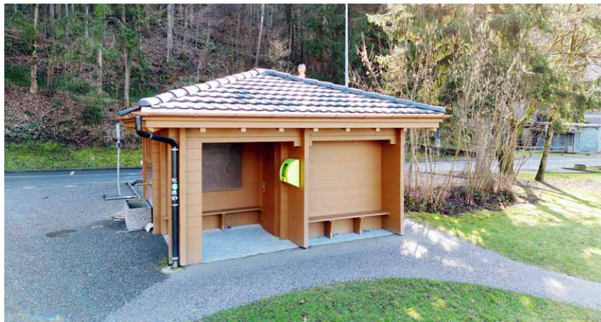
Die WC-Anlage in Rütenen erstrahlt in neuem Glanz.
