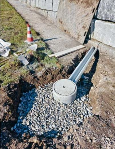
Anpassung Entwässerung und Ersatz der Kofferschicht
