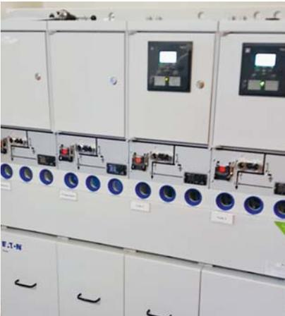
Die neue Mittelspannungsschaltanlage in der TS Pumpstation
